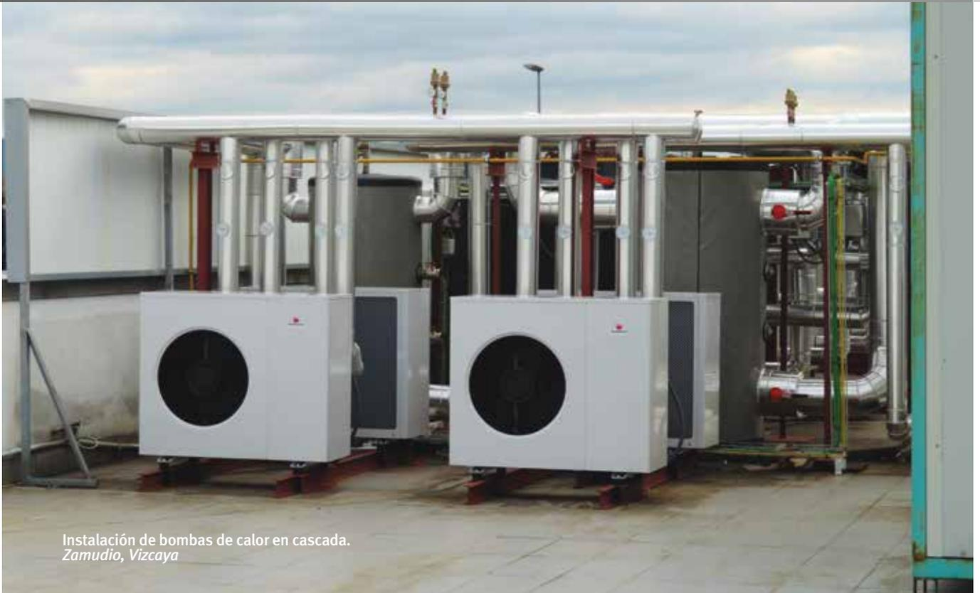
Instalación de bombas de calor en cascada.
