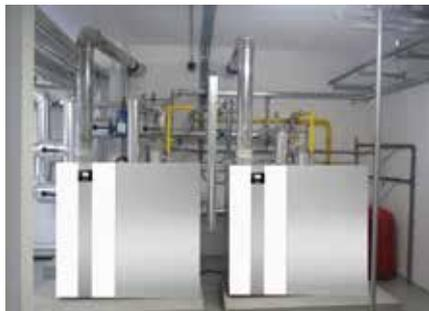
**Conjuntos térmicos de condensación a gas homologados como generador único**
